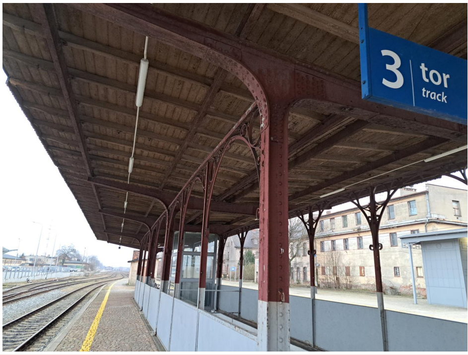
Fot. nr 3. Widok północnego skraju wiaty w obrębie strefy schodów dwustronnego zejścia do przejścia podziemnego. W skró-cie perspektywicznym widoczny układ dwusłupowych stalowych ram głównych, a także tworzących rytm głównego architektonicznego podziału wiaty oraz stanowiących konstrukcję wsporczą balustrad zabezpieczających krawędzie światła zejścia.do przejścia podziemnego, zwieńczonych lukami i wolutami słupków pośrednich . W odniesieniu do historycznego kontekstu architektury wiaty, zwraca uwagę stosunkowo agresywny układ współ-czesnych białych opraw oświetleniowych oraz zasilających te oprawy przewodów elektrycznych.
