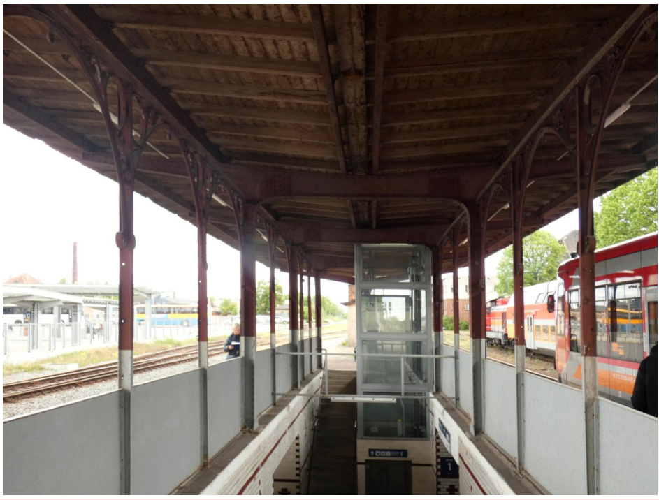
Fot. nr 2. Widok wiaty od str. zachodniej w obrębie wnętrza strefy schodów dwustronnego zejścia do przejścia podziemnego. Wido-czny układ dwusłupowych stalowych ram głównych wiaty z dodatkowymi wysuniętymi na zewnątrz wspornikami pod stalo-we płatwie nośne drewnianej konstrukcji dachu. Między ramami głównymi w strefie zejścia występują dodatkowe słupki pośrednie od góry zwieńczone ozdobnymi lukami i wolutami wykonanymi z teownika i płaskownika stalowego. Wprawdzie wbudowany od strony wschodniej, przesklony szyb windy dla osób niepełnosprawnych mocno zawężił wschodni bieg schodów, nie zmienił on jednak historycznego dwustronnego charakteru wyjścia z przejścia podziemnego. Prosta współczesna architektura tego szybu jest neutralna w stosunku do historycznego kontekstu architektury wiaty.
