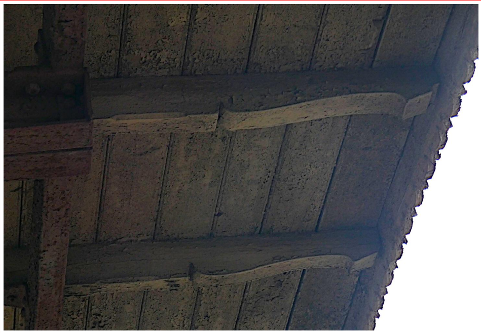
Fot. nr 3. Widok drewnianego detalu architektonicznego drewnianej konstrukcji nośnej oraz drewnianego poszycia pod bitumiczne pokrycie dachu wiaty. Dobrze widoczne jest profilowanie krawędzi deskowania dachu oraz profilowania krawędzi i końcówek krokwi. Stan techniczny pokrycia z desek jest zły, co oznacza, że prawdopodobnie w całości będzie ono musiało być wymienione na nowe. Stan techniczny krokwi jest bardziej zróżnicowany, jednak należy się spodziewać, że ich górne partie na styku mocowania z deskami będą w znacznym stopniu zniszczone. Oznaczałoby to konieczność wymiany dużej części a może nawet całości krokwi. Pełna ocena zakresu tej wymiany będzie jednak możliwa w trakcie prac remontowych po demontażu pokrycia z papy oraz deskowania dachu.
