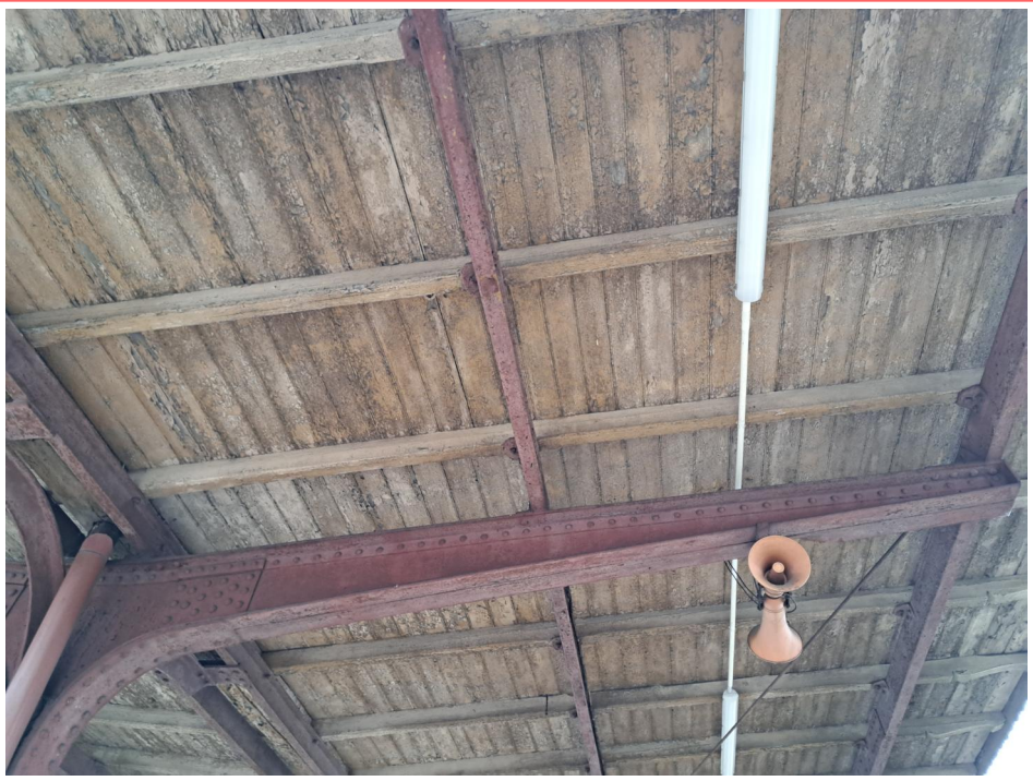
Fot. nr 2. Widok fragmentu konstrukcji zachodniej części wiaty na styku wspominków skrajnego słupa stalowego. Widoczne wy-prowadzenie rury odpływowej odwodnienia dachu przez deskowanie drewnianej konstrukcji jego poszycia. Tak jak na całych połaciach konstrukcji dachowej wiaty, widoczny jest zły stan zabezpieczenia powierzchniowego oraz znaczny stopień zniszczenia deskowania pod pokrycie z papy. Ten stan, w połączeniu z widocznym na zdjęciach z drona stanem technicznym papy, wskutek braku szczelności dachu, licznych przecieków i zawilgocenia drewna, wpływa na jego postępującą degradację. Podobnego stanu drewna należy spodziewać się w przypadku krokwi dachu, zwłaszcza na styku ich górnych płaszczyzn z deskowaniem pokrycia. Stan nitowanej konstrukcji stalowej można ocenić jako ogólnie dobry, wymaga ona jednak, po usunięciu zniszczonych powłok malarskich, dokładnego sprawdzenia oraz, w razie potrzeby - lokalnych napraw, a następnie ponownego zabezpieczenia antykorozyjnego i wykonania wykończeniowej powłoki malarskiej odtwarzającej pierwotną kolorystykę wiaty.
