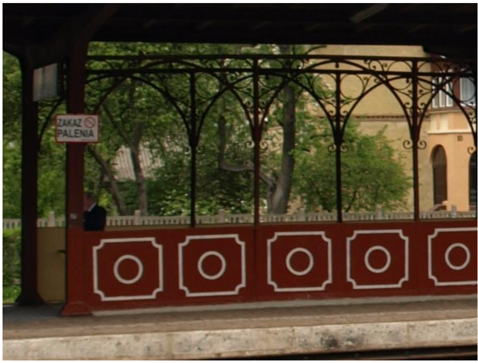
Fot. nr 6. Widok porównawczy części wiaty od strony południowo - zachodniej, przy balustradzie osłaniającej światło schodów zachodniego zejścia do przejścia podziemnego, na archiwalnym zdjęciu wykonanym w 2016 roku, przed zamalowaniem dolnych partii wiaty szarą farbą antykorozyjną. Przemalowanie to w znacznym stopniu zatarło pierwotnie kolorystycznie wyeksponowany detale architektoniczny tej części wiaty, przez co detal ten z większej odległości stał się mało czytelny.
