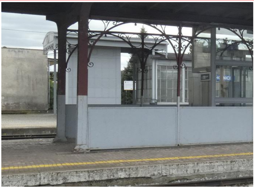
Fot. nr 4. Widok części wiaty od str. północno - wschodniej, przy schodach wschodniego zejścia do przejścia podziemnego. Zwraca uwagę płaska płaszczyzna zewnętrznej balustrady osłaniającej światło zejścia, która pozbawiona jest tworzących dodatkowy podział architektoniczny, nałożonych w formie płycin obramowań i rozet z płaskownika stalowe-go, które zastosowane zostały w balustradzie zlokalizowanej po przeciwnej stronie wiaty. Słupy ram głównych, słupki pośrednie oraz stalowe balustrady przemalowane są w kolorze szarym, zapewne w celu doraźnego zabezpieczenia antykorozyjnego ich konstrukcji stalowej. Przemalowanie to jednak zatarło wcześniejszą kolorystykę dolnych partii wiaty.
