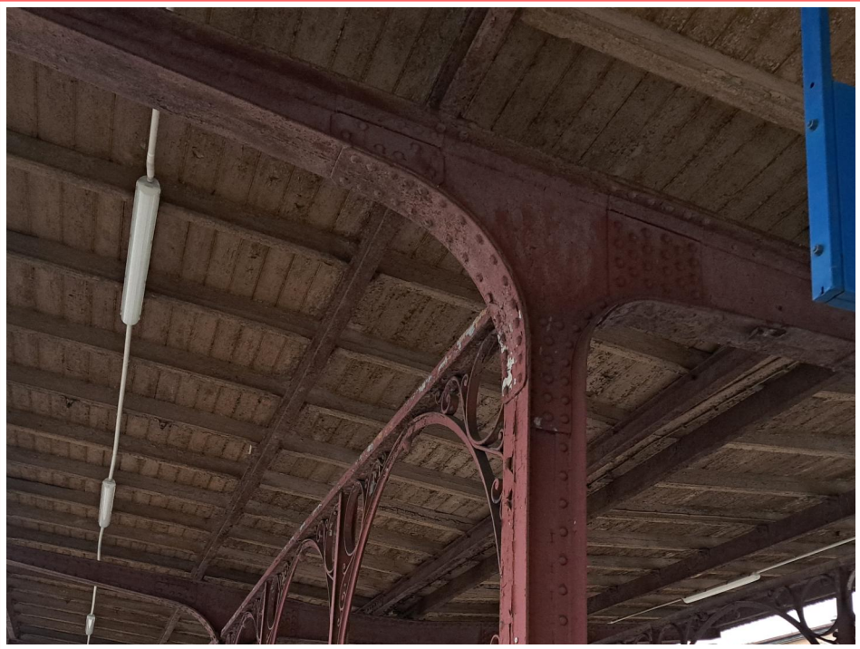
Fot. nr 3. Widok fragmentu zachodniej części wiaty w strefie pierwszej dwusłupowej ramy jej nitowanej konstrukcji nośnej, zlokalizowanej przy zachodnim biegu schodów zejścia do przejścia podziemnego. Dobrze widoczny detale łuków i wolut, od góry zwiędających przesterzenie między słupami konstrukcji głównej wiaty i wstawionymi między nie słupkami pośrednimi. Główne łuki wypełnień mają profil teowy, natomiast wypełnienia wolutami wykonane są ze stalowego płaskownika. Cała nitowana konstrukcja główna wraz z dodatkowymi słupkami pośrednimi i ażurowymi arkadami wypełnień, stanowią logiczny i spójny układ kompozycyjny typowy dla funkcjonalnie rozbudowanych wiat stalowych budowanych przy obiektach kolejowych na początku XX wieku. Widoczny na zdjęciu stan zachowania drewnianej konstrukcji przekrycia jest identyczny jak w pozostałych częściach wiaty. Dodatkowo na zdjęciu zwraca uwagę dysonans między zamontowaną pod drewnianą konstrukcją dachu współczesną instalacją oświetlenia peronu nr 1 oraz historyczną architekturą zabytkowej wiaty. Jak wynika z historycznych planów dworca, pierwotnie peron oświetlały klasyczne latarnie.
