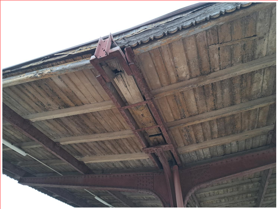
Fot. nr 1. Widok fragmentu zachodniego szczytu wiaty. Zwraca uwagę stan techniczny krawędzi szczytowej drewnianej konstrukcji pokrycia. Pierwotnie starannie wykończona, obecnie znajduje się w stanie zaawansowanej destrukcji. Koronkowo profilowana deska szczytowa zamykająca południową połać dachu jest popekana i wykazuje liczne ubytki. Na połaci północnej deski szczytowej brak, widoczny jest natomiast stan postępującego zniszczenia końcówek deskowania dachu. Zniszczona jest także deska wykończenia spodu styku połaci w osi wiaty. Pozostała część deskowania wykazuje zróżnicowany stan zachowania. Generalnie można go uznać jako zły, ponieważ stan spodu desek wskazuje na duże zwiędzenie drewna, wykończeniowe powłoki malarskie są na nich całkowicie zniszczone i złuszczone, widoczne są liczne ślady przecieków, lokalne ubytki drewna wskutek wskutek procesu jego degradacji biologicznej itp. Zwraca uwagę także zły stan powłok malarskich zabezpieczających konstrukcję stalwą wiaty. Są one także w znacznej części odspojone i złuszczone, wskutek czego widoczne są liczne ogniska korozji stali. Z ogólnej oceny wynika jednak, że jest to korozja powierzchniowa.
