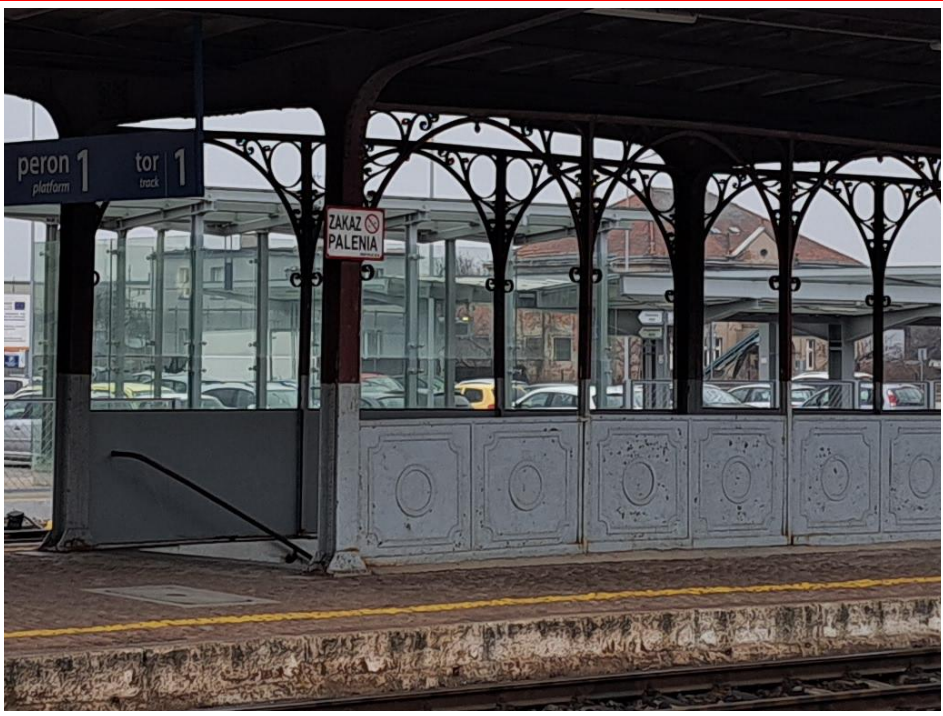
Fot. nr 5. Widok części wiaty od str. południowo - zachodniej, przy schodach zachodniego zejścia do przejścia podziemnego. Płaszczyzna zewnętrznej balustrady osłaniającej światło zejścia, od strony zewnętrznej posiada dodatkowe podziały architektoniczne w postaci tworzących płyciny, nałożonych obramowań i rozet z płaskownika stalowego. Podziałów tych nie ma jednak od wewnętrznej strony tej balustrady oraz w balustradzie osłaniającej światło zejścia od strony północnej. Słupy ram głównych, słupki pośrednie oraz stalowe balustrady, podobnie jak po stronie przeciwnej, zostały doraźnie zabezpieczone szarą farbą antykorozyjną która zatarła wcześniejszą kolorystykę dolnych partii wiaty z kolorystycznie wyodrębnionym detalem podziałów architektonicznych balustrady.
