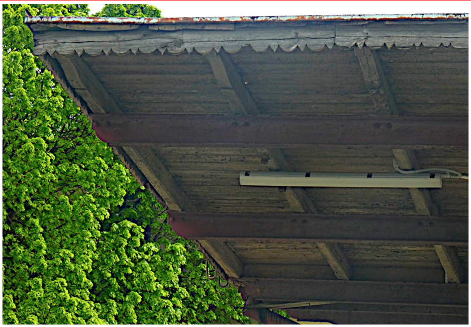
Fot. nr 5. Widok fragmentu północno - wschodniego narożnika konstrukcji pokrycia dachu. Koronkowo profilowana deska okapowa w tym miejscu zachowała w całości swoją pierwotną geometrię, jednak jest ona mocno popekana a struktura drewna - mocno zwiędła. Może ona jednak posłużyć jako wzór do odtworzenia detalu i profilowania nowych desek szczytowych i desek okapowych. Na zdjęciu widoczny jest także stan zaawansowania korozji stalowych płatwi konstrukcji nośnej dachu. Wg wstępnej oceny jest to korozja powierzchniowa. Występuje ona jednak na dużych powierzchniach i jest to proces postępujący, wymagający interwencji oraz prac naprawczych i zabezpieczających.
