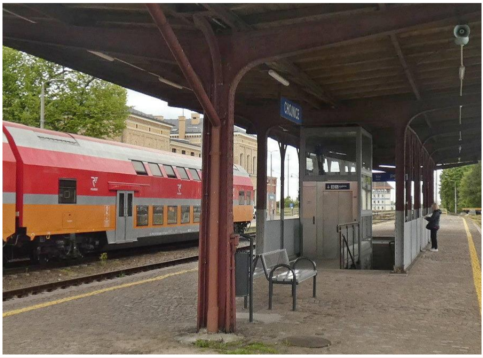
Fot. nr 1. Widok części wiaty od str. południowo - wschodniej. Na pierwszym planie widoczny ustawiony osiowo skrajny dwu-wspornikowy słup stalowy wspierający nitowaną konstrukcję wschodniej części wiaty przed dwustronnymi schodami zejścia do przejścia podziemnego. Wschodnia część tych schodów została w 2024 roku zawężona wskutek wbu-dowania w ich obręb szybu z windą dla osób niepełnosprawnych. Widoczna drewniana konstrukcja krokwiowego dachu opartego na stalowych płatwiach łączących poszczególne ramy konstrukcyjne wiaty. Połacie dachu ustawione są ze spadkiem do osi wiaty, z odwodnieniami poprzez rury spustowe mocowane do skrajnych słupów jej konstrukcji nośnej.
