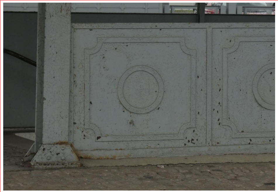
Fot. nr 4. Widok fragmentu wypełnienia zlokalizowanej od strony południowej peronu balustrady zabezpieczającej światło zejścia do przejścia podziemnego. Wypełnienie wykonane jest z blachy stalowej z dodatkowymi, tworzącymi płyciny nakładkami wykonanymi z płaskownika. Pierwotnie nakładki te były zróżnicowane kolorystycznie, natomiast obecnie, zapewne w celu zabezpieczenia antykorozyjnego dolnych partii konstrukcji stalowej, cała balustrada oraz słupy wiaty są zamalowane w kolorze szarym. Mimo tego lokalnie zauważyć można przebijające się przez powłokę farby ogniska korozji. Balustrada zabezpieczająca po przeciwnej stronie światła zejścia pozbawiona jest dodatkowych płycinowych nakładek z płaskownika stalowego.
